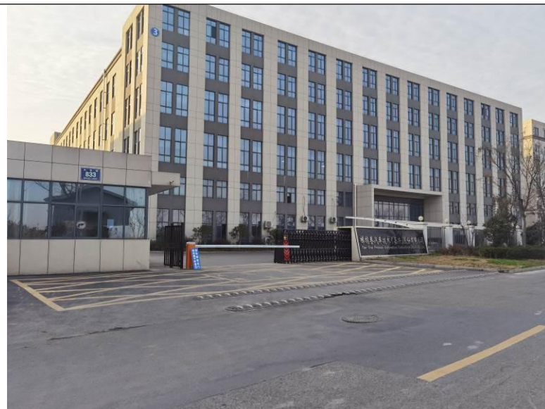
厂区北侧为空地
