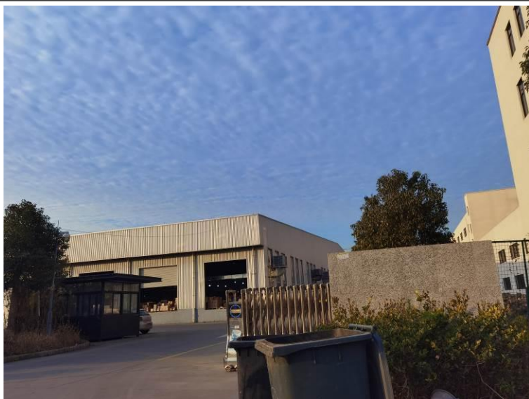
厂区西侧为浙江卫星石化股份有限公司
