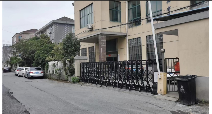
厂区北侧为嘉兴市德尔森新材料科技有限公司
