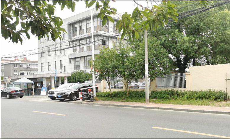
厂区东侧为嘉兴海盛电子有限公司（百盛光电）
