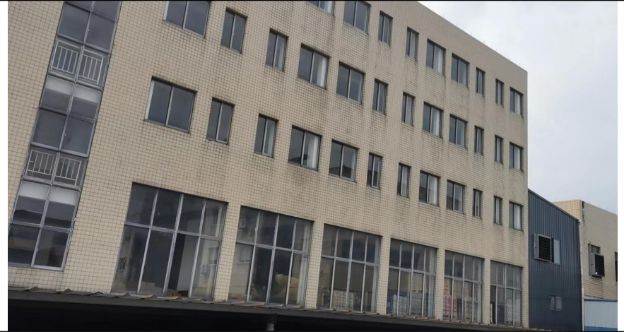
厂区南侧为嘉兴金耐可五金制品股份有限公司
